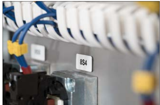
Etiquettes pour identification de boutonerie Helatag 1220 - Adhésif haute performance qui assure une adhérence optimale sur des surfaces irrégulières.
