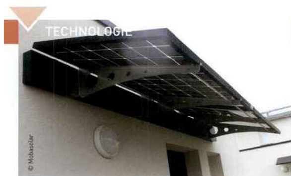
Des capteurs PV en marquise selon Mobasolar.
