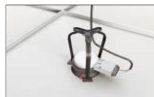
4. Passez le câble d'alimentation dans la patte de fixation.
