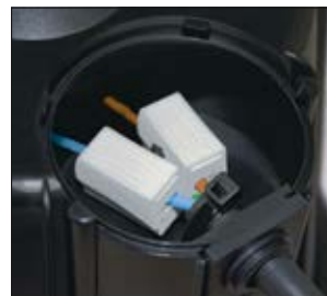
HelaCon Lux connecté au transformateur.
