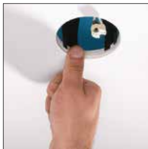
2. Enfoncer les ergots dans la plaque de plâtre pour prévenir tout désalignement ultérieur du système.
