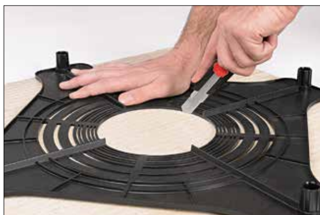
Positionner le SpotClip-Plate sur la plaque minérale (600 x 600 mm) avant de la découper.
