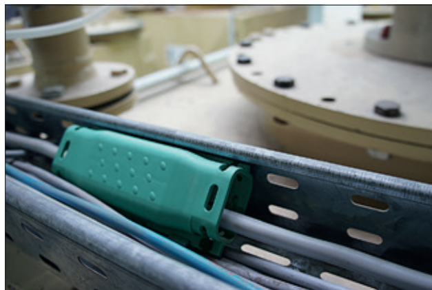
Kit de raccordement à gel intégré, utilisé pour la réparation de câbles „MRO“.
