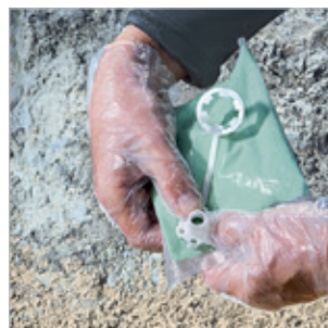
Ouverture de la pochette automatique et étanche grâce à l'installation de la buse de remplissage
