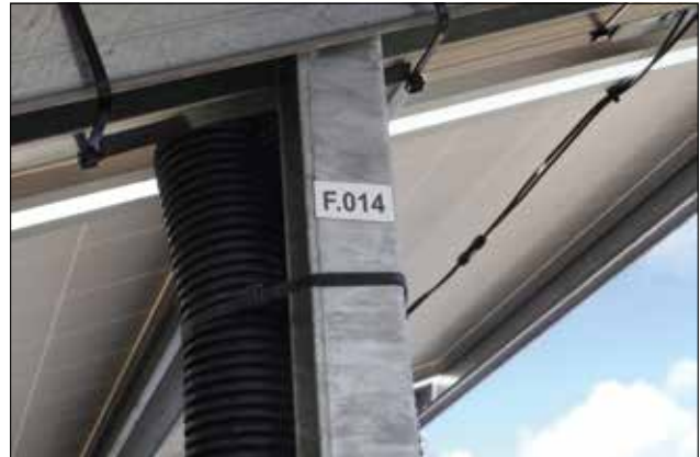
Solution idéale pour remplacer les plaques gravées : ces étiquettes imprimées sont durables en utilisation extérieure.
