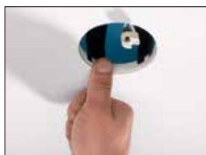
Enfoncer les ergots dans la plaque de plâtre pour prévenir tout désalignement ultérieur du système.
