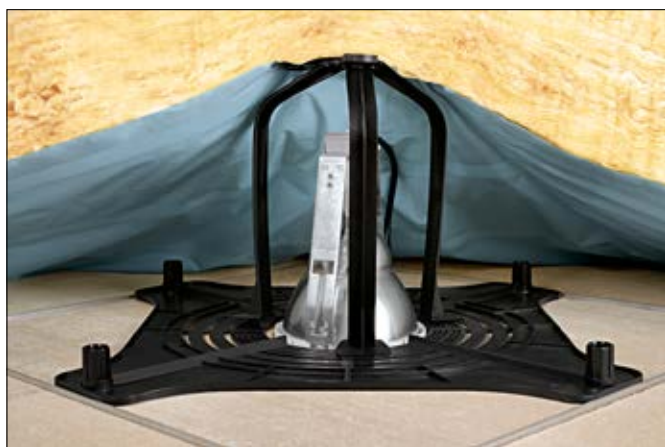
Łączenie kołpaka SpotClip-Kit z płytką SpotClip-Plate.
