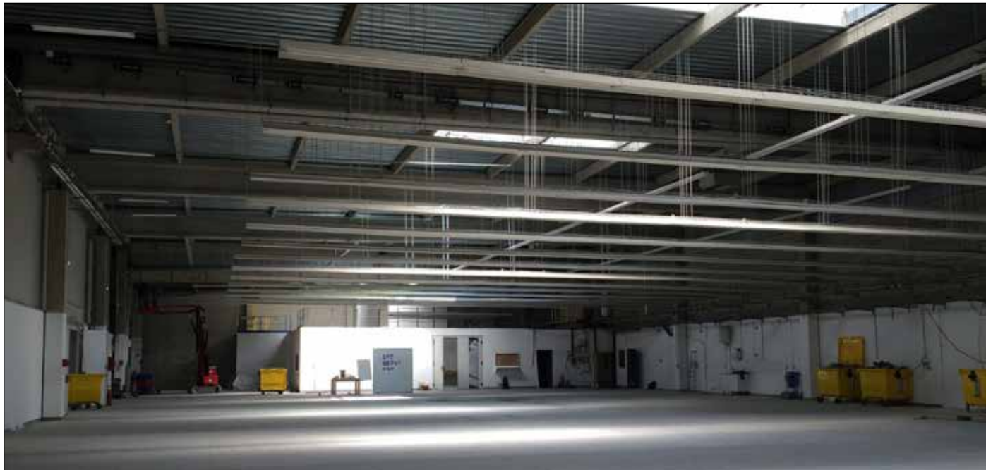
Le futur site de Trappes 2 avant travaux.
