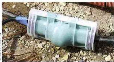
Boîte basse tension souterraine avec connecteur tétrapolaire.
