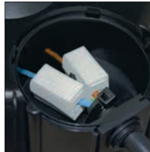
HelaCon Lux connecté au transformateur.
