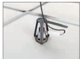
4. Passer le câble d'alimentation dans la patte de fixation si nécessaire. Poser la laine de verre.
