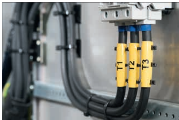
TAGUL - Repères pour l'identification des câbles et des faisceaux.
