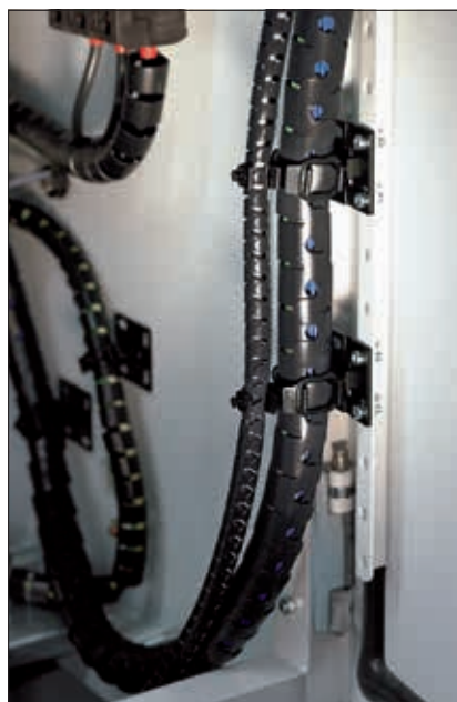
La gaine Helawrap est utilisée partout où une grande flexibilité est requise, comme à l'intérieur de panneaux électriques.
