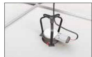
4. Passer le câble d'alimentation dans la patte de fixation si nécessaire. Poser la laine de verre.
