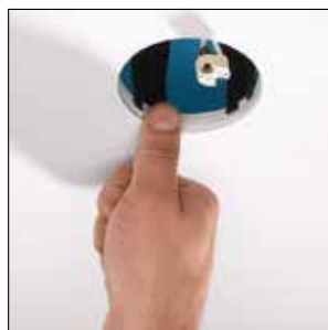
3. Enfoncer les ergots dans la plaque de plâtre pour prévenir tout désalignement ultérieur du système.
