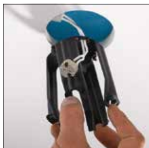
1. Comprimer les pattes de montage et insérer dans l'ouverture du plafond.
