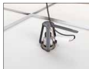
4. Passer le câble d'alimentation dans la patte de fixation si nécessaire. Poser la laine de verre.
