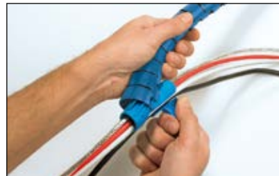
Placez l'outil d'installation à une extrémité de la gaine.
