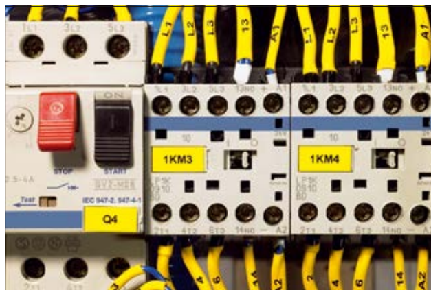
Gaine thermorétractable ferroviaire à faible degré de nuisance.
