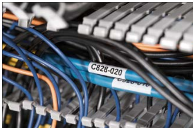
Les étiquettes Helatag 1209 offrent une excellente protection contre l'abrasion et les intempéries.
