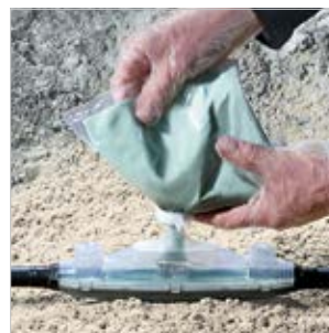
Le bec verseur associé à son adaptateur permet de remplir le boîtier de manière efficace et rapide
